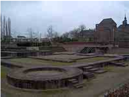
Figuur 8: Fundamenten van het voormalige kasteel Hedel.
